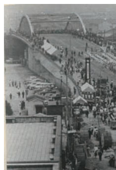
蒲田陸橋開通 (昭和37年)
