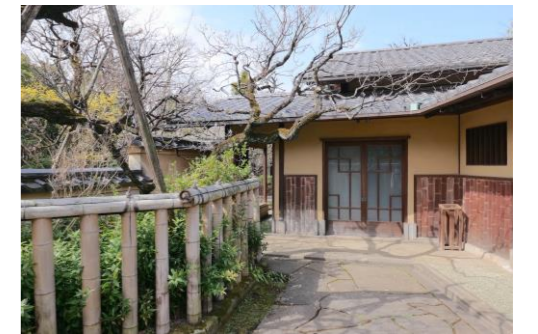
図 旧川端龍子邸(主屋)の外観
